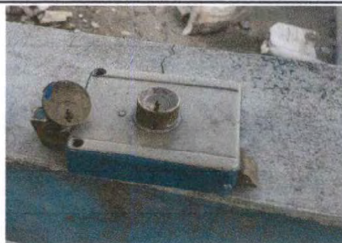
Foto 2: Sustitución de chapa.
