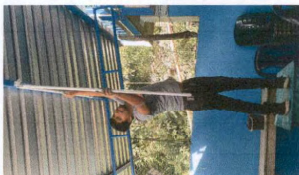
Foto 9: Sustitución de lámparas de 2x40 y sustitución de plafoneras
