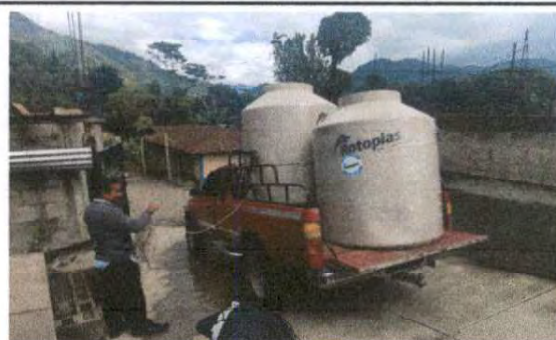
Foto 10: Sustitución depósito de agua 1000 lt.
