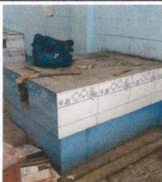
Foto 15: Instalación de azulejo en estufas rurales
