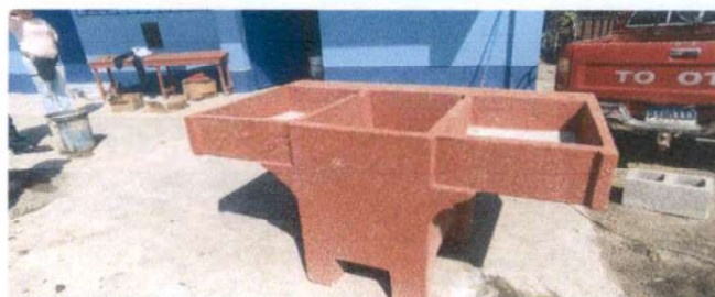
Foto 16: Sustitución de pila de cemento de dos lavaderos.
