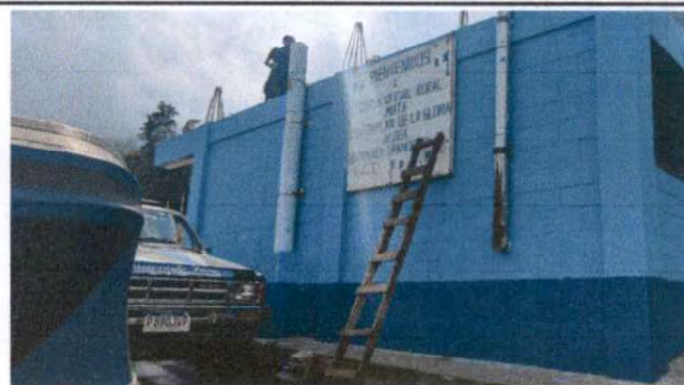
Foto 14: Sustitución de chimenea de metal
