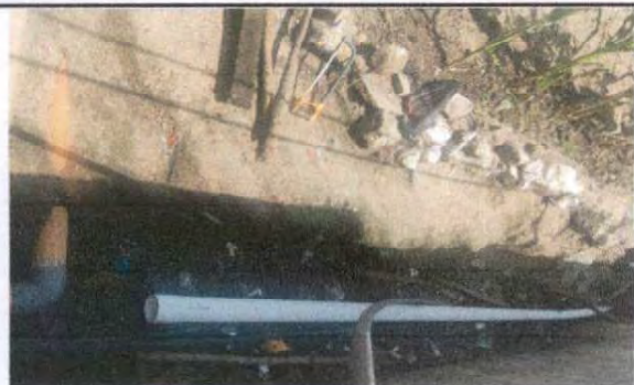
Foto 7: Sustitución de tubería PVC línea principal aguas negras.
