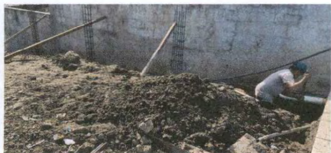
Foto 3: Reparación de piso de torta de concreto
