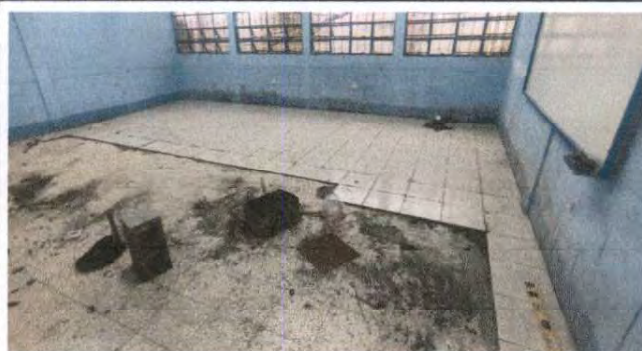
Foto 4: Sustitución de piso de granito
