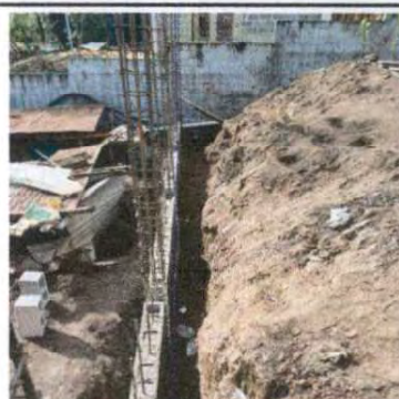
Foto 8: Reparación de muro perimetral de block y reparación de piso de torta de concreto.
