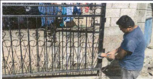
Foto 6: Mantenimiento a portones de metal
