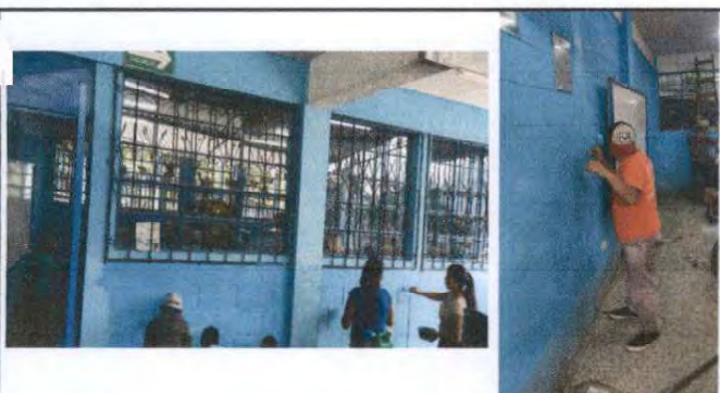
Foto 5: Pintura en muros exteriores e interiores
